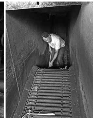
サトウキビ搬入コンベアの改修作業中のアイクさん
